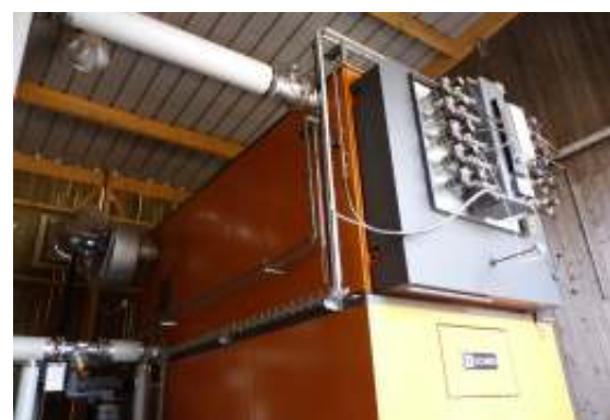
La chaudière et ses ramoneurs pneumatiques, photo FD
